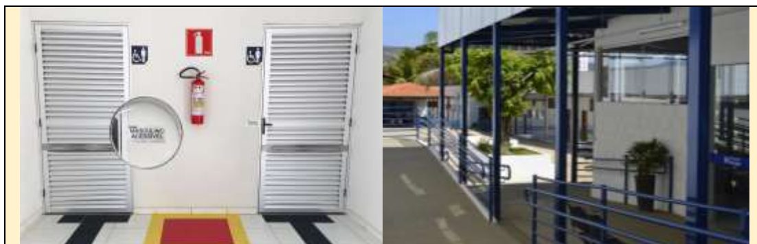
Acessibilidade nos sanitários e área interna da IES
