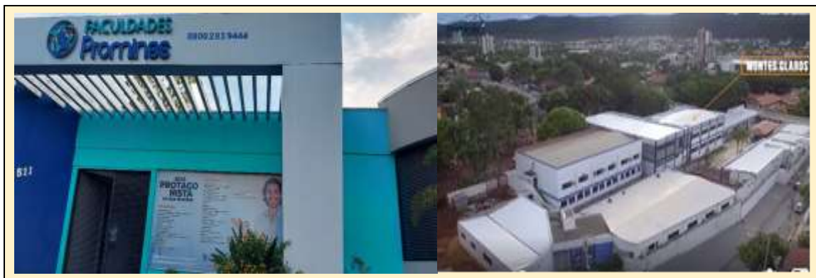
Fachada da IES e imagem aérea do prédio
